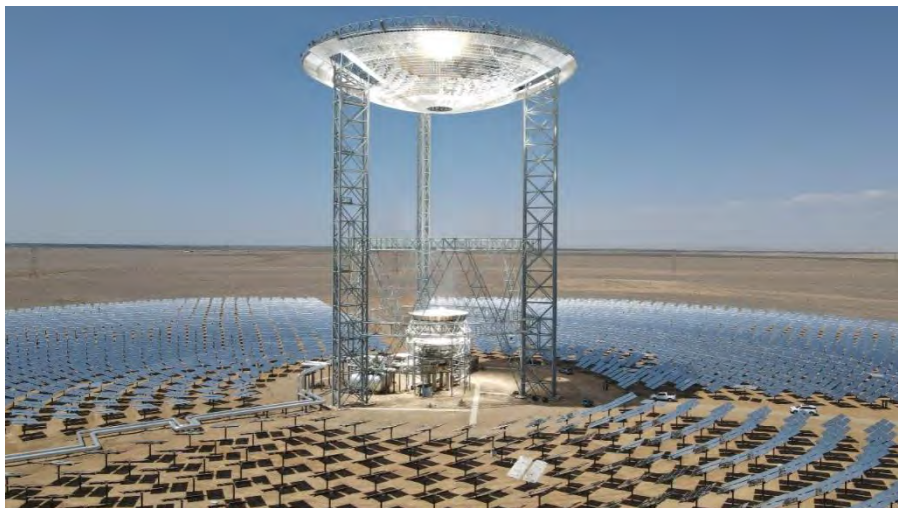
图 7 二次反射塔式太阳能热发电系统现场运行照片 (图片来源: 众擎光热)
