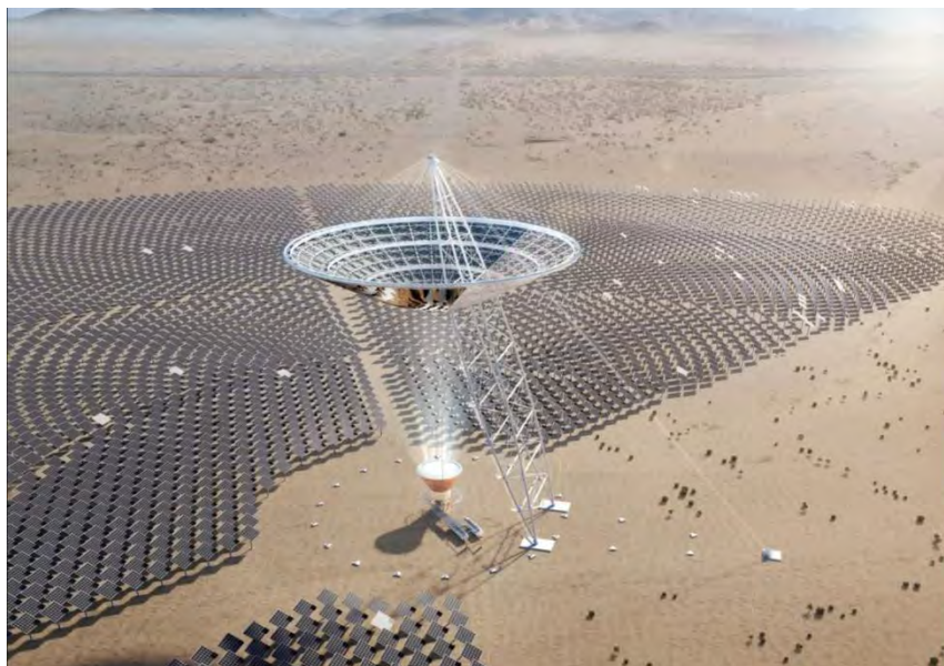
图 9 斜拉索二次反射塔式高倍聚光集热系统示意图 (图片来源: 众擎光热)
